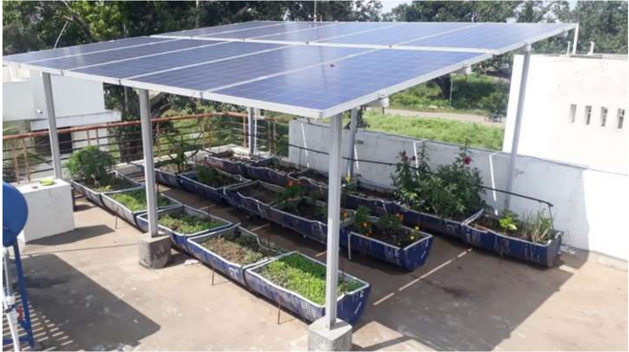
Figura 13: Ejemplo de un sistema Agrovoltaico residencial de aproximadamente 10 metros cuadrados [31]
