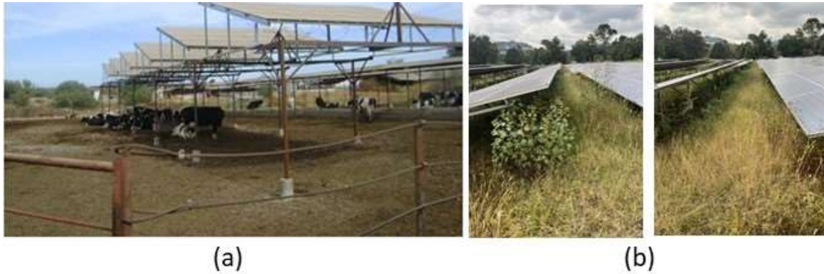
Figura 5: En (a) se muestra el uso dual de un terreno, tanto para generar electricidad como para hacer sombra al ganado; en (b) se muestran los pasillos de mantenimiento en una planta solar fotovoltaica instalada sobre el suelo sin tener una vocación agrícola que reditúe frutos al propietario (fotos propias).
