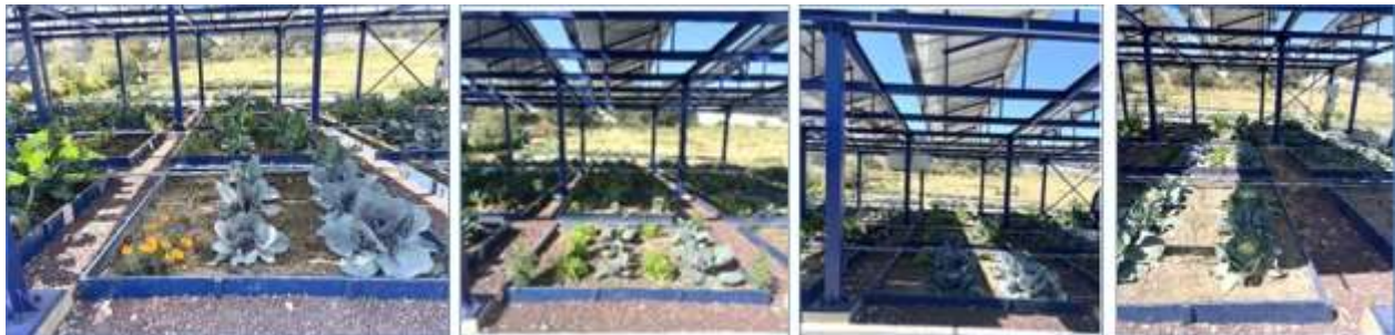
Figura 7: Efecto de luz y sombra proyectado por un arreglo fotovoltaico de 6 hileras, cada una con 12 MFV, espaciadas 1.45 m a una altura de 3.54 m
