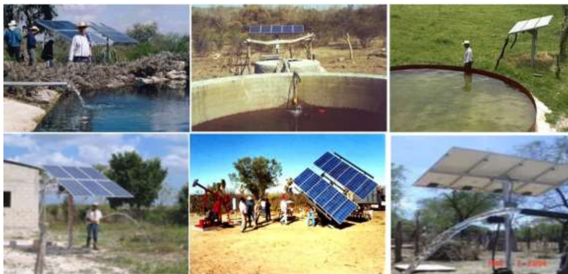
Figura 2: Sistemas Fotovoltaicos para abrevaderos de ganado e irrigación de cultivos (Fotos propias).
