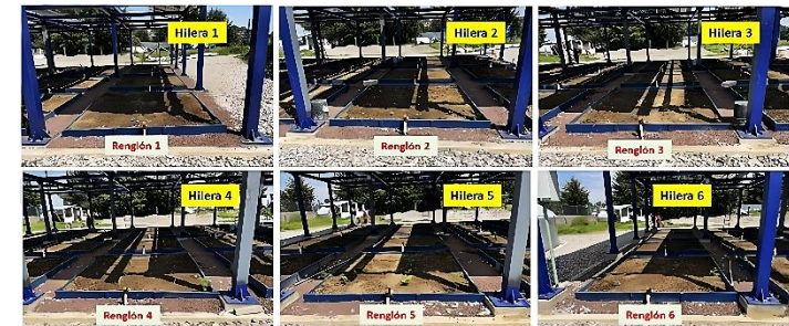
29 de septiembre de 2023, 13:55 h. Vista Oeste a Este
